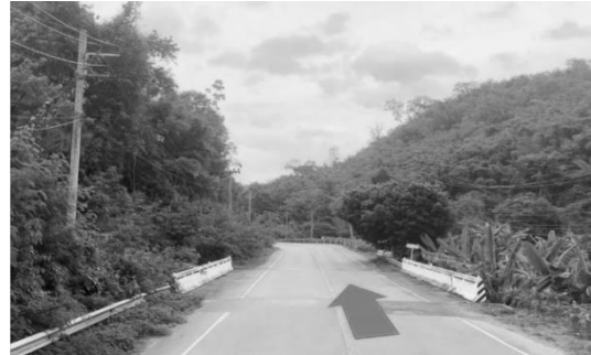
กม.21+768 สะพานข้ามห้วยสามสบ กว้างประมาณ 11.00 เมตร
