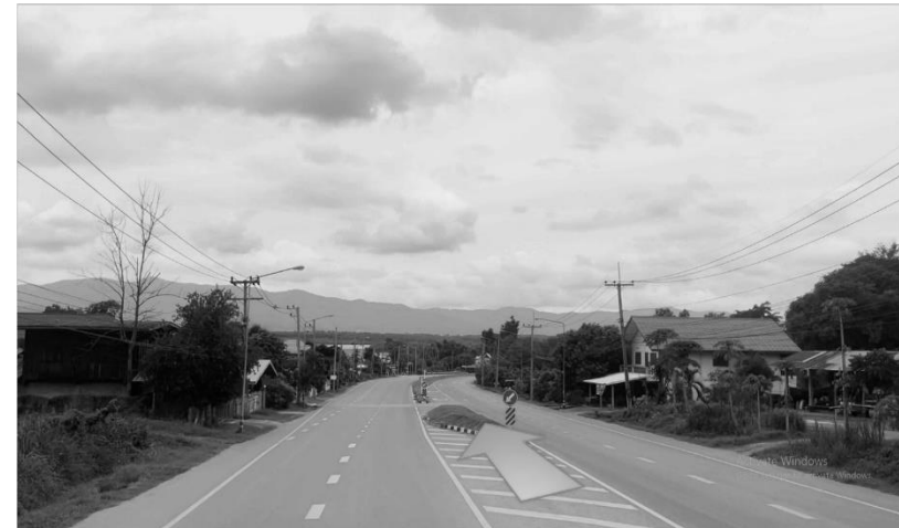
กม.31+100 จุดสิ้นสุดโครงการ บนทางหลวงหมายเลข 1026 ผิวทางแอสฟัลท์ ขนาด 4 ช่องจราจร
