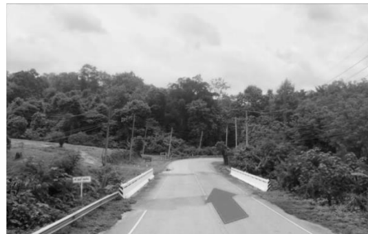
กม.23+563 สะพานข้ามห้วยสามสบ กว้างประมาณ 10.00 เมตร
