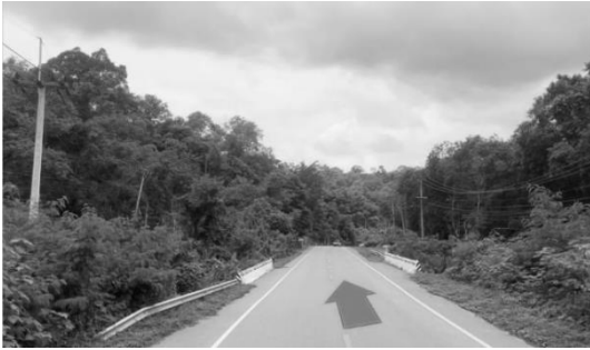
กม.18+908 สะพานข้ามห้วยสามสบ กว้างประมาณ 11.00 เมตร
