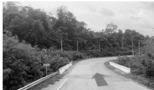
กม.22+910 สะพานข้ามห้วยสามสบ กว้างประมาณ 11.00 เมตร
