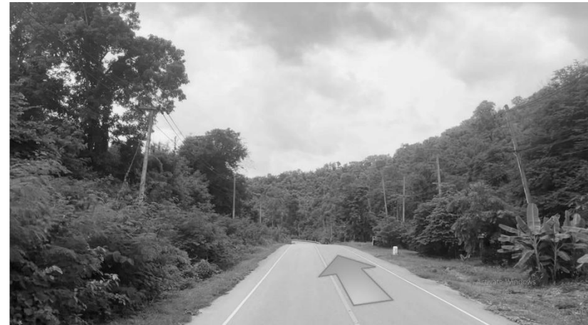
กม.23+000 ลักษณะภูมิประเทศเป็นทางเขา สองข้างทางเป็นพื้นที่ป่าไม้
