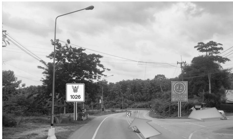
กม.29+260 แนวทางหลวงโครงการ ตัดกับทางหลวงชนบท นน 3003 เป็น 3 แยก
