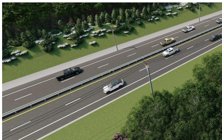
รูปที่ 5.2.3-2 รูปแบบเกาะกลางแบบราวเหล็กกันอันตราย (Guardrail Median)
